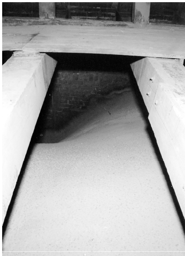
Fot. 33. Fragment sklepienia po zakończeniu prac
