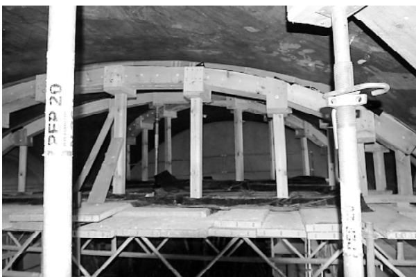
Fot. 3. Podpory żeber sklepienia
