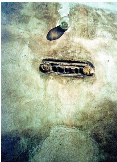
Fragment głowicy kolumny widoczny na zewnętrznej ścianie parteru. Fot. W. Klag
