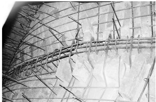
Fot. 28. Początek zbrojenia żebra poprzecznego
