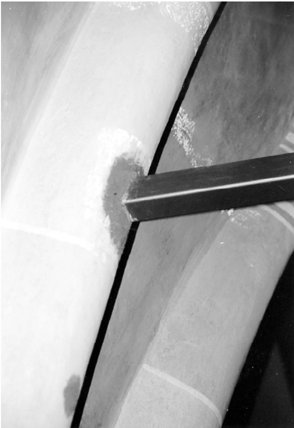
Fot. 9. Fragment wykonanego ściągu
