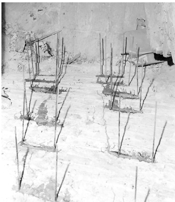
Fot. 16. Fragment powierzchni grzbietowej sklepienia z osadzonymi kotwami
