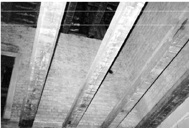
Rys. 4. Odślonięte belki stropu drewnianego nad salą I piętra
