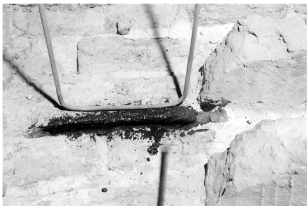
Fot. 14. Kotwa przed osadzeniem w spoinie
