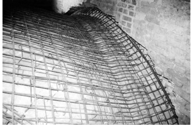
Fot. 25. Widok zbrojenia podwójnego w pobliżu wieńca podporowego
