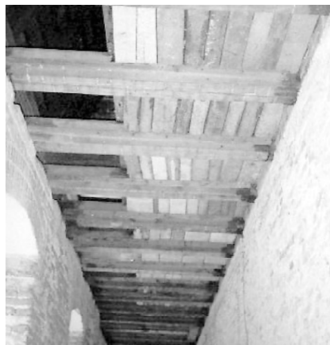
Rys. 5. Odślonięte belki stropu drewnianego nad korytarzem
