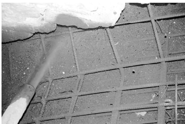
Fot. 30. Detal torkretowania wieńca podporowego
