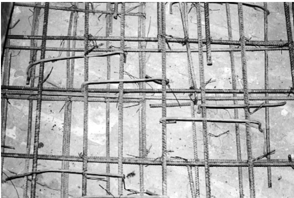
Fot. 23. Szczegół mocowania kotew do zbrojenia
