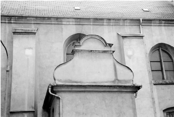
Fot. 8. Miejsca kotwienia ściągow w przyporach
