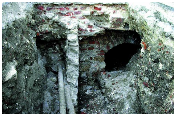
Wykop w rejonie północno-wschodniego narożnika Sukiennic wykonany w 2003 roku z widocznym murem fundamentowym arkad i reliktem wtórnej ściany działowej kramów (fot. autor)
