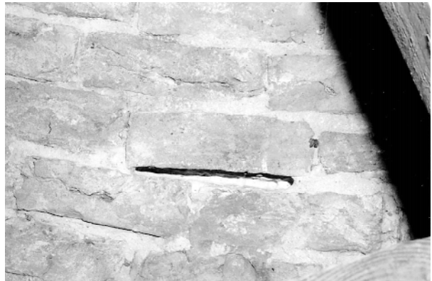
Fot. 12. Wysoka spoina między cegłami przeznaczona do osadzenia kotwy
