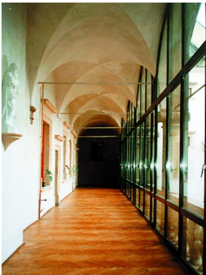
Nowa ściana osłonowa na piętrze, umożliwiającą pełną ekspozycję arkad. Fot. W. Klag
