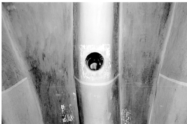
Fot. 6. Otwór w ścianie zewnętrznej przeznaczony do montażu ściągu
