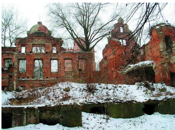
Fot. 2. Widok pałacu od strony wschodniej
