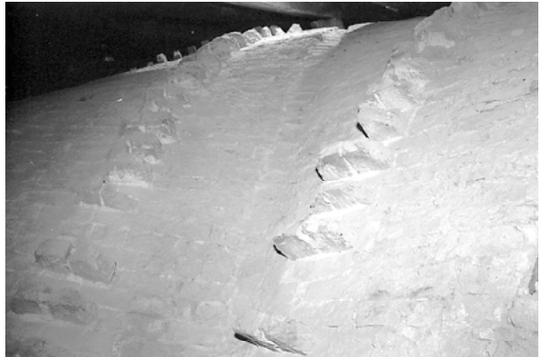
Fot. 11. Fragment oczyszczonej strony grzbietowej sklepienia
