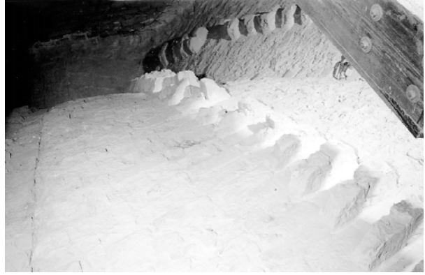
Fot. 10. Fragment oczyszczonej strony grzbietowej sklepienia
