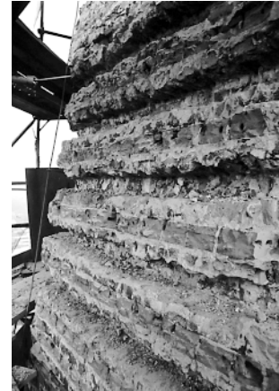
Rys. 13. Pierwszy etap renowacji – usunięcie zniszczonej warstwy licowej
