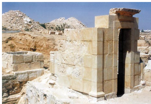
Ryc. 13. Marina El-Alamein. Kiosk zejścia do hypogeum T1GH po anastylozie i konserwacji (fot. autor)
