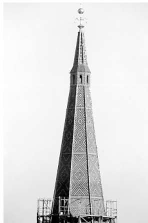
Rys. 18. Hełm wieży po renowacji
