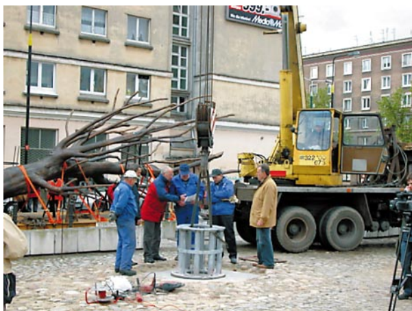
Pawiak, prace przy posadowieniu Drzewa
