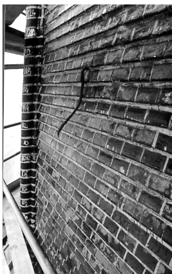
Rys. 7. Powierzchnia hełmu pokryta czarnym nalotem sadzy
