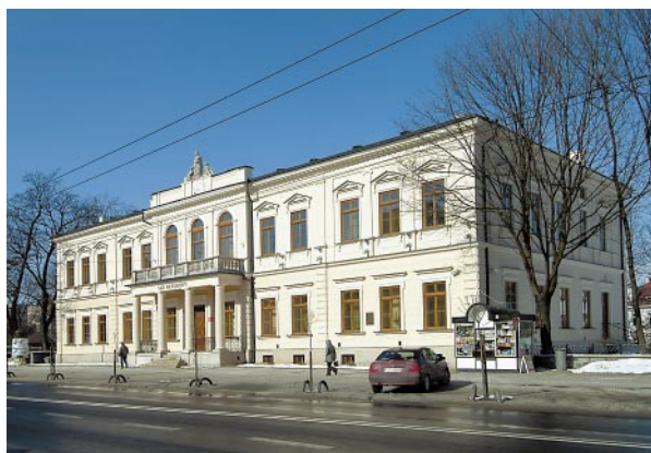
Lublin, elewacja frontowa budynku Sądu Okręgowego
