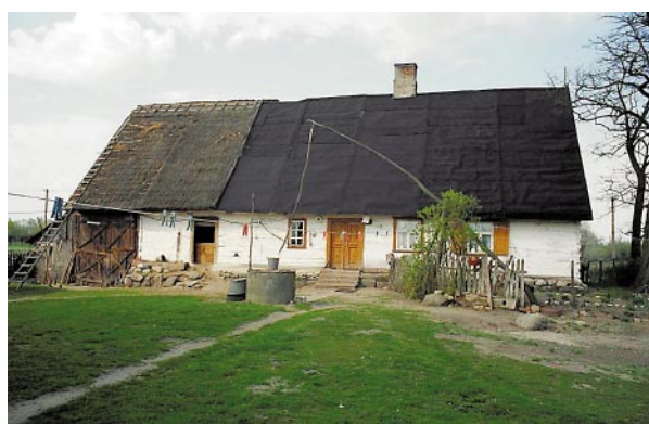
Dom ze wsi Życk Polski 61, gm. Słubice – w chwili obecnej stan zachowania tego pięknego obiektu jest tragiczny – niestety został przeznaczony on do rozbioru
