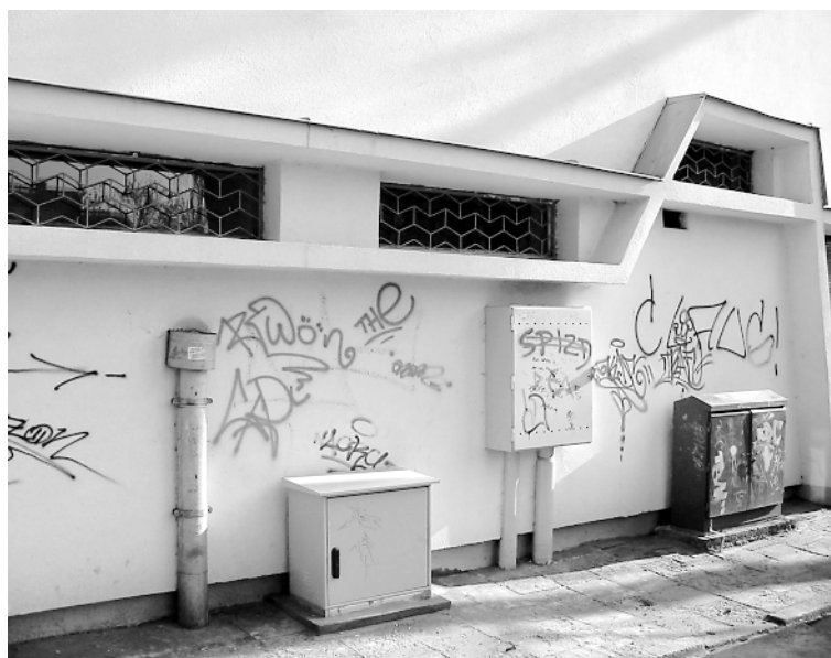
„Detal” techniczny kontra detal architektoniczny, ul.Senatorska w Krakowie
