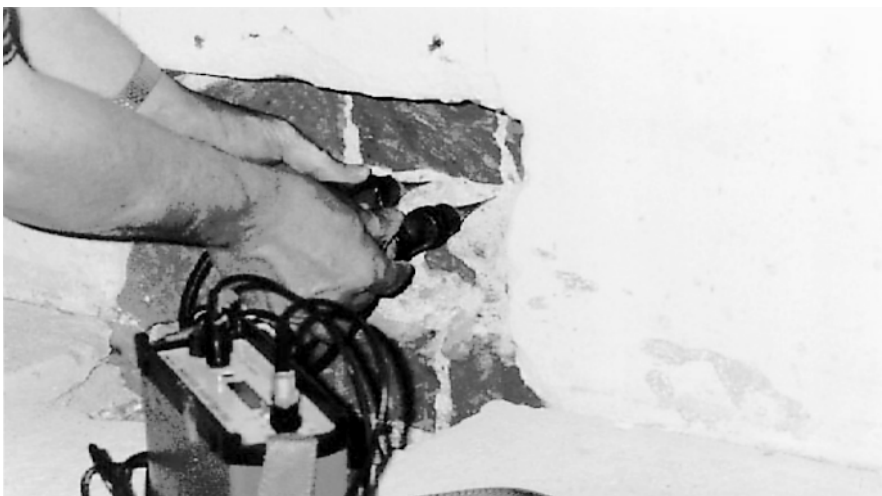
Rys. 4. Sposób badania zaprawy między ceglami z wykorzystaniem głowic eksponencyjnych
