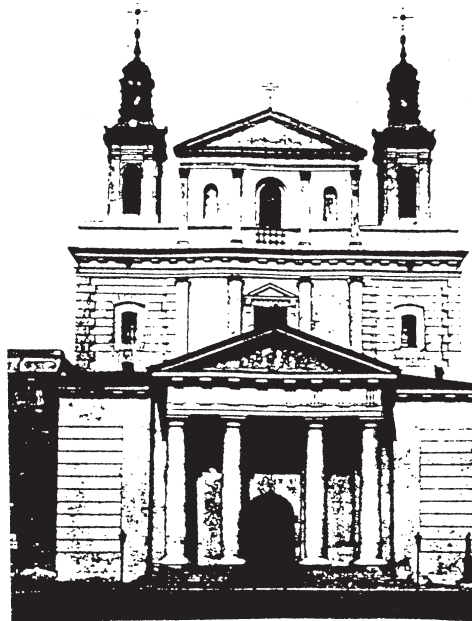
2c. Elewacja frontowa Kościoła oo. Jezuitów w Lublinie (fasada ukończona w 1853 r.)
