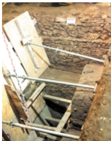
Ryc. 3. Widok na zachodni mur magistralny południowo-wschodniego budynku Kramów Bogatych i fragment wschodniego muru magistralnego trzeciego budynku XIII-wiecznych Sukiennic (fot. T. Kalarus)
