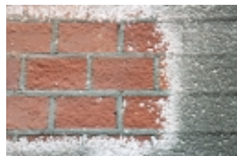
Metoda piaskowania i mikropiaskowania. Użycie agregatów pracujących metodą strumieniową, gdzie odpowiednio dobranym ścierniwem pod regulowanym ciśnieniem usuwa się warstwę z lica cegły
