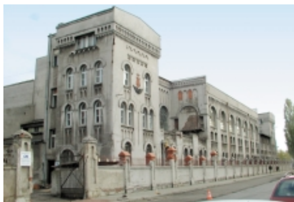
Budynek dawnej Elektrowni Tramwajowej w Warszawie – 1905. Elewacje budynku pokryte w latach 70. warstwą obrzutki cementowej
