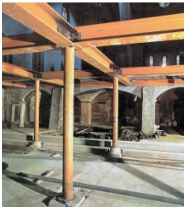
3. Florencja, Katedra Santa Maria Del Fiore: montaż konstrukcji nośnej stropu nad podziemnym rezerwatem bazyliki Santa Separata
