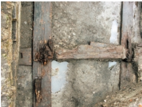
Ryc. 14. Widok z góry. Widoczny brak połączenia belki podwalinowej z położoną po lewej stronie podstawą przypory (fot. M. Gawlicki)
