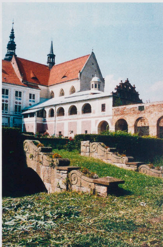
W wyniku porozumienia z ks. Henrykiem Kardynałem Gulbinowiczem Ośrodek Ochrony Zabytkowego Krajobrazu podjął prace rewaloryzacyjne Ogrodów Klasztornych w Henrykowie.
