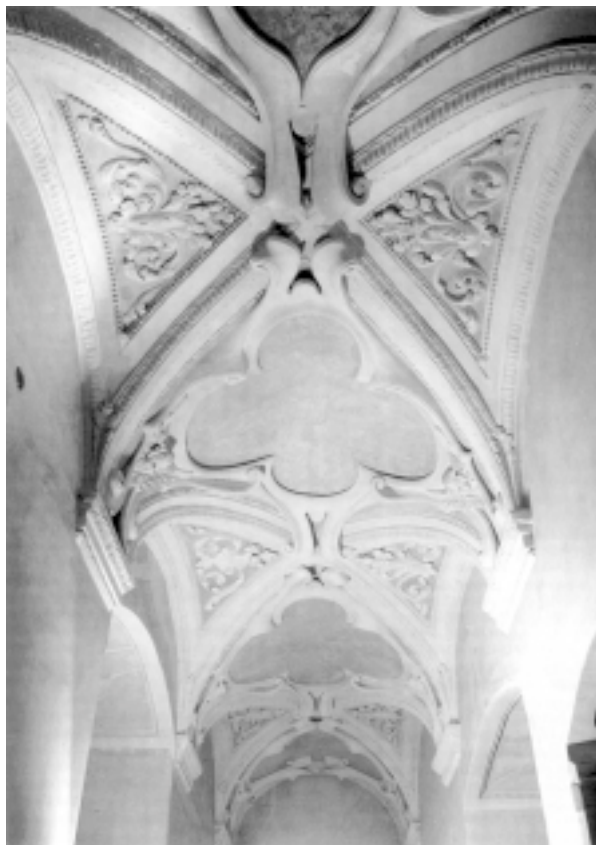
Ryc. 11. Sztukateria Falconiego w chórze kaplicy po konserwacji Fig. 11. Falconi's stucco in the chapel choir after conservation
