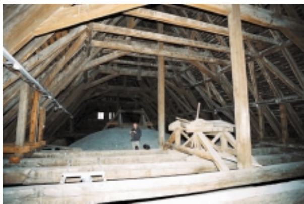
Ryc. 1. Widok ogólny poddasza z zabytkową więźbą dachową i kołowrotem (fot. M. Warchoł)
