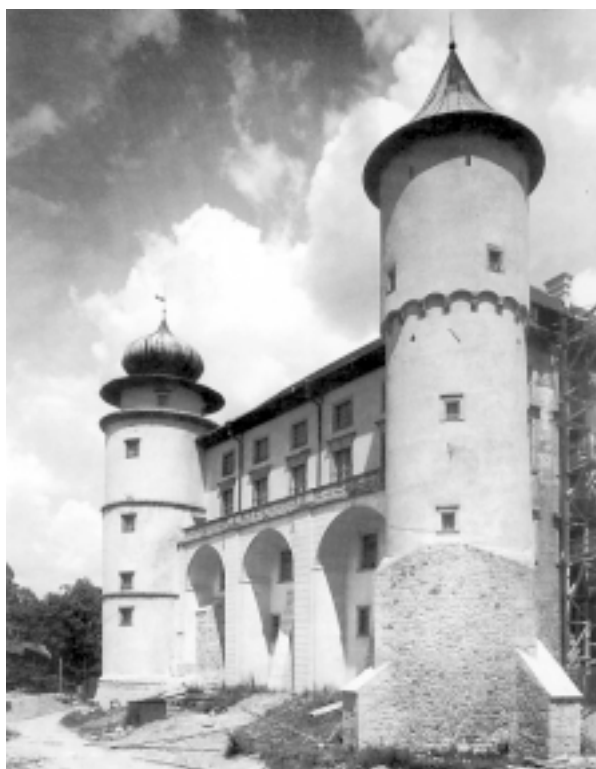
Ryc. 3. Elewacja zachodnia zamku po konserwacji Fig. 3. Western elevation of the castle after conservation
