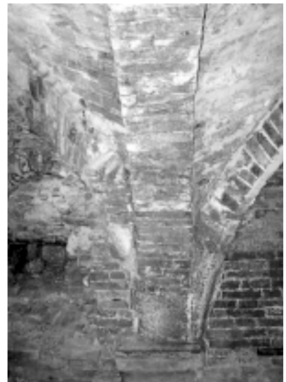
Ryc. 5. Klasztor cystersów w Jędrzejowie, ściana zachodnia cellarium, widoczny przysięenny kamienny wspornik gurtu oraz kamienne wsporniki żeber sklepiennych. Fot. A. Bojęś-Białasik, 2009 Fig. 5. The Cistercian monastery in Jędrzejów, the west wall of the cellarium, a stone corbel supporting a flying buttress is visible and stone corbels of vault ribs. Photo: A. Bojęś-Białasik, 2009
