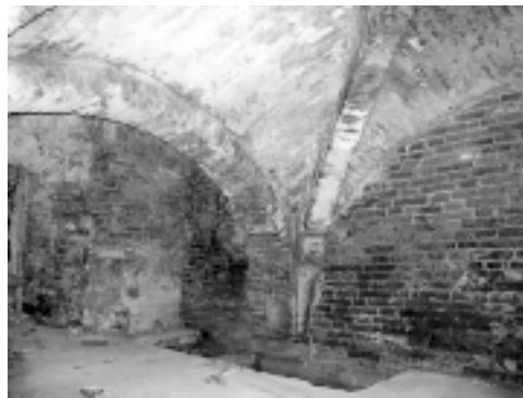
Ryc. 4. Klasztor cystersów w Jędrzejowie, widok ściany zachodniej cellarium pod refektarzem, z widocznym wlotem do urządzenia piecowego. Fot. archiwalna: K. Musiał, 1997; fot. stanu obecnego A.Bojęś-Białasik, 2009 Fig. 4. The Cistercian monastery in Jędrzejów, view of the west wall of cellarium under the refectory, with a visible inlet to the heating device. Photo: archives K. Musiał 1997; photo of the present state by A. Bojęś-Białasik, 2009
