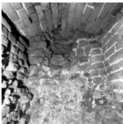
Ryc. 16. Północna ściana magistralna piwnicy (i pieca) z wtórnie wykutym kanałem dymowym pieca. Fot. Archiwalna T. Szklarczyk 1989 Fig. 16. The north load-bearing wall of the cellar (and the stove) with a secondarily made flue from the stove. Photo: archive, T. Szklarczyk 1989
