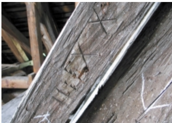
Ryc. 3. Ciesielski znak montażowy nawiązujący do cyfr rzymskich (fot. D. Mączyński)
