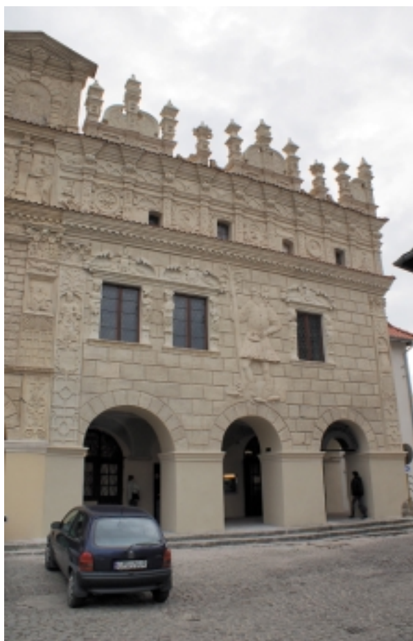
Ryc. 6. Elewacja frontowa kamienicy „Pod św. Krzysztofem” w Kazimierzu Dolnym nad Wisłą Fig. 6. Front elevation of the tenement house “Under St. Christopher” in Kazimierz Dolny on the Vistula
