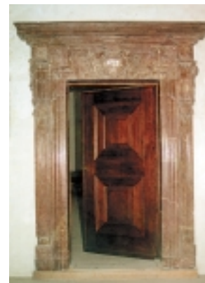
Ryc. 7. Portal w komnacie II piętra po konserwacji Fig. 7. Portal in a second floor chamber after conservation
