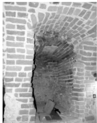
Ryc. 13. Widok ściany południowej pieca z otworem wlotowym, w głębi widoczne wnętrze komory. Fot. A. Bojęś-Białasik, 2009
