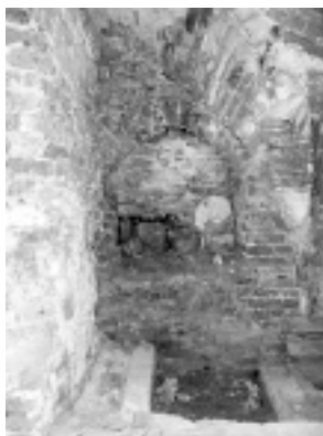
Ryc. 6. Klasztor cystersów w Jędrzejowie, cellarium pod refektarzem, ściana zachodnia z widocznym – częściowo zamurowanym wlotem do urządzenia piecowego. Fot. A. Bojęś-Białasik, 2009 Fig. 6. The Cistercian monastery in Jędrzejów, cellarium under the refectory, the west wall with a visible, partially walled-in opening to the stove-like device. Photo: A. Bojęś-Białasik, 2009
