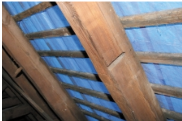
Ryc. 6. Ślady po rozszczepianiu drewna (fot. D. Mączyński)
