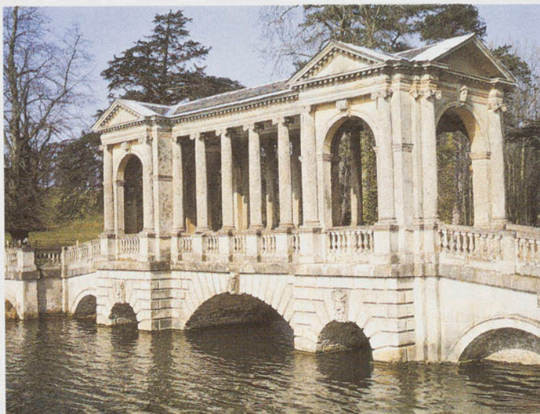
Ogrody – The Palladian Bridge. Wybudowany w 1739 przez J. Briggisa odrestaurowano w latach 90. XX wieku
