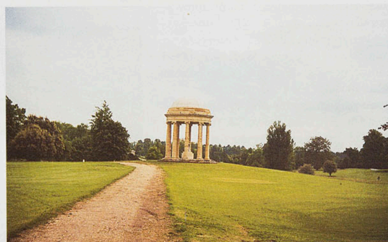
Ogrody – Rotunda. Prace renowacyjne tej budowli J. Gibbsa ukończono jesienią 1999 (fot. B. Furmanik)
