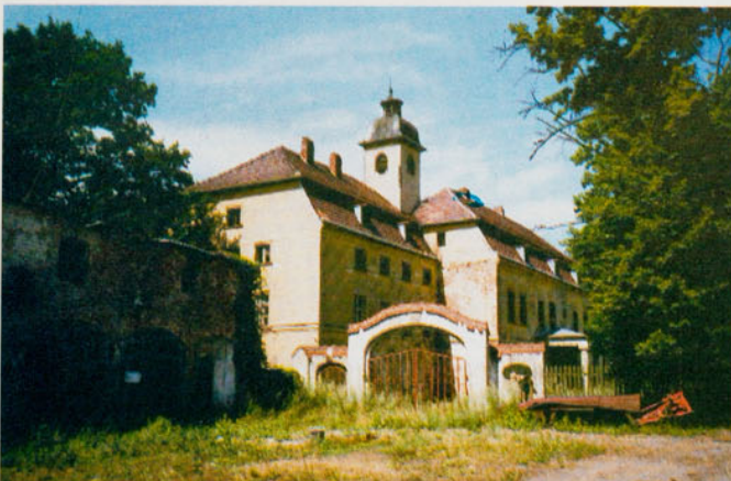
Pałac w Dębince
