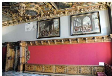
Ryc. 10. Widok na ścianę wschodnią po wykonaniu obicia suknem według historycznego podziału kolorystycznego. W górnej części pozostawiono „okienka” umożliwiające oglądanie gotyckich malowideł (fot. K. Darecka, 2010 r.)
