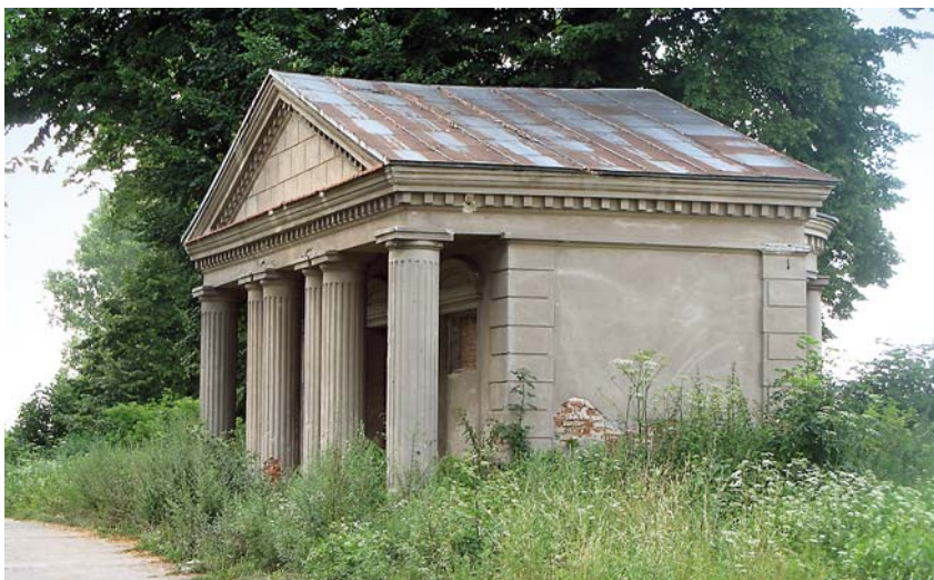
Ryc. 9. Kaplica dworska w Boratynie, stan obecny, fot. J. Kobylarczyk 2011 Fig. 9. The manor chapel in Boratyn, current state, photo by J. Kobylarczyk 2011
