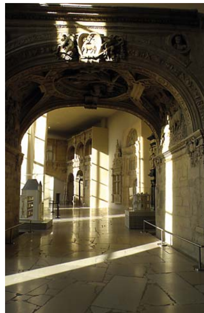
Ryc. 10. Galeria dodana przez Jacquesa Carlu w 1937 r. po konserwacji. Fot. autora, grudzień 2011 Fig. 10. Gallery added by Jacques Carlu in 1937, after conservation. Photo by author, December 2011
