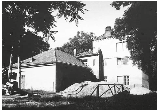
Ryc. 4. Dwór w Boratynie. Widok na elewację wschodnią przed remontem, fot. J. Salamon, 1987, w: I. Zając, Boratyn. Założenie dworsko-parkowe , op. cit., il.6 Fig. 4. Manor house in Boratyn. View of the east elevation before the renovation, photo by J. Salamon, 1987, in: I. Zając, Boratyn. Założenie dworsko-parkowe , op. cit., il.6
