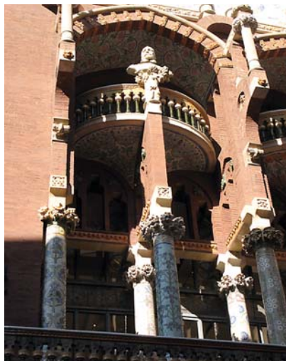
Ryc. 13. Palau de la Música Catalana – detal elewacji frontowej, fot. K. Dudzic-Gyurkovich Fig. 13. Palau de la Música Catalana – detail of the front elevation – photo by K. Dudzic-Gyurkovich
