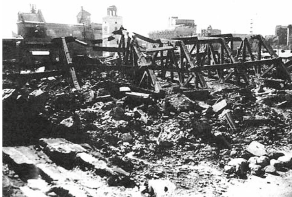
Ryc. 1. Warszawa – Zamek Królewski. Ruiny zamku przed pracami porządkowymi – 1948 r. Fot. ze zbiorów autorki Fig. 1. Warszawa – the Royal Castle. Castle ruins before clearing – 1948. Photo from the Author's collection
