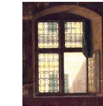
Ryc. 5. Okno z dekoracyjnym oszkleniem szybkami oprawionymi w ołowiane szpros, północna ściana Wielkiej Sali Rady. Fragment obrazu Heinricha Hansena z ok. poł. XIX w.
