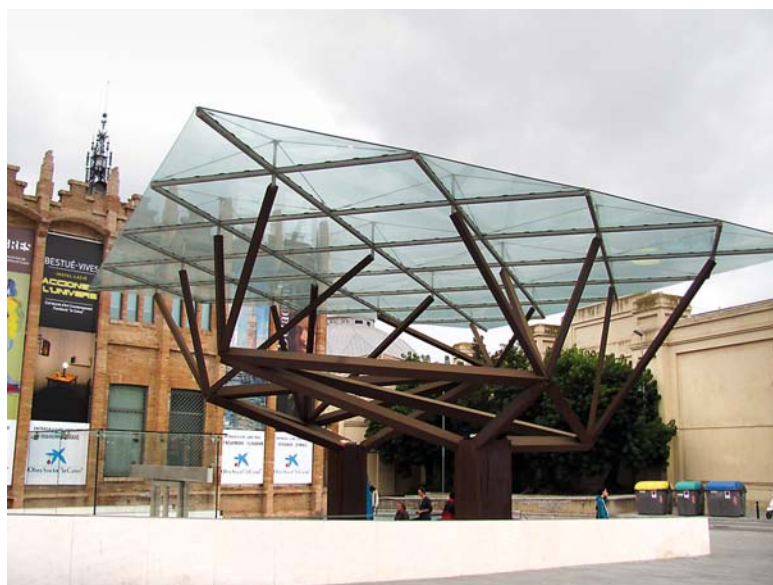
Ryc. 11. Caixa Forum – przekrycie schodów ruchomych w zewnętrznej strefie wejściowej, fot. autor Fig. 11. Caixa Forum – roof covering of the escalators in the outer entrance zone – photo by author
