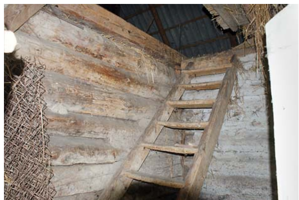
Ryc. 8. Dom drewniany nr 13 Fig. 8. Wooden house no 13
