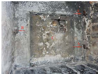
Ryc. 3. Wnętrze wnęki: a) haki po zawiasach drzwiczek, b) otwór do zasuw, c) zamurowanie z ok. 1594 r.
