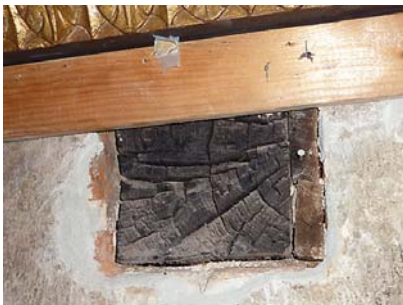
Ryc. 2. Gniazdo z fragmentem spalonej belki pochodzącej z pierwotnego stropu
