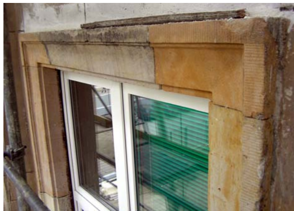
Ryc. 12. Widok odczyszczonych w trakcie remontu elementów kamieniarskiej oprawy okna na elewacji od strony dziedzińca wewnętrznego budynku D1 – różnobarwny kamień zostanie następnie scalony metodą laserunkową. Fot. J. Piskozub, 2013 r.
