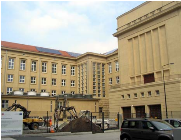
Ryc. 15. Widok elewacji budynku Wydziału Elektrycznego D1 od strony dziedzińca wewnętrznego – w trakcie renowacji. Stan z 2013 roku. Fot. J. Piskozub, 2013 r.
