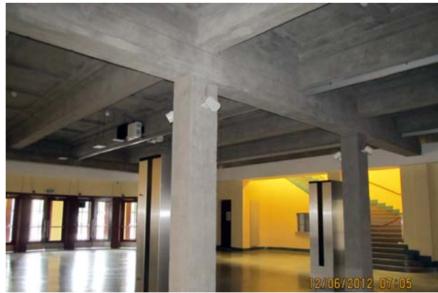
Ryc. 5. Hall wejścia głównego do budynku przed i po zdemontowaniu stropu podwieszanego Fig. 5. Main entrance hall before and after removal of the suspended ceiling
