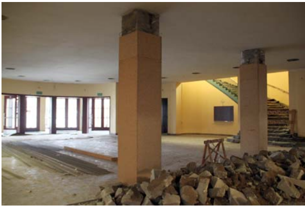
Ryc. 5. Hall wejścia głównego do budynku przed i po zdemontowaniu stropu podwieszanego Fig. 5. Main entrance hall before and after removal of the suspended ceiling
