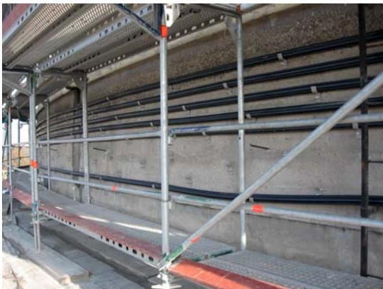
Ryc. 3. Wzmocnienia dolnego wieńca rozciąganego – układanie kabli i zabezpieczenie z zaprawy (fot. R. Dzugaj)
