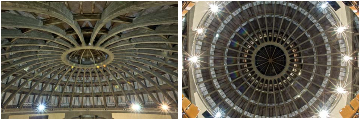
Ryc. 1. Kopuła żebrowa Hali Stulecia (fot. M. Goleń)
