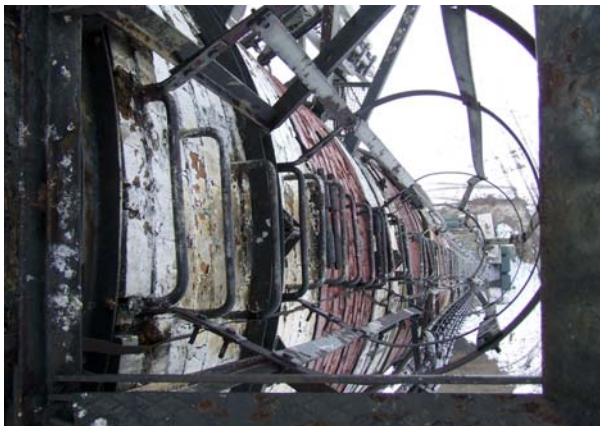
Ryc. 6. Stan powierzchni płaszcza w górnej partii komina Fig. 6. The jacket surface condition in the upper part of the chimney
