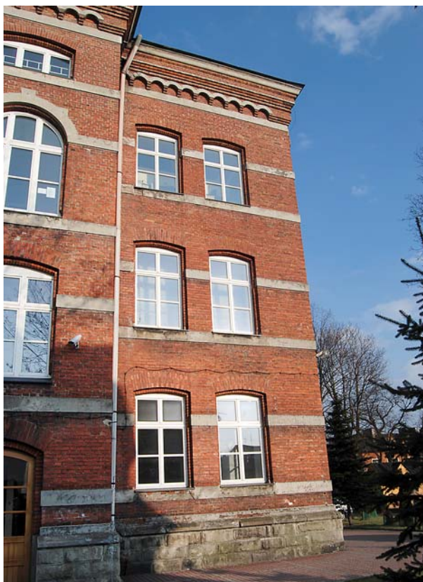
Ryc. 18. Widok na elewację boczną (zachodnią) dawnego Gimnazjum, obecnie liceum S. Goszczyńskiego w Nowym Targu. Fot. M. Krupa, 2016
