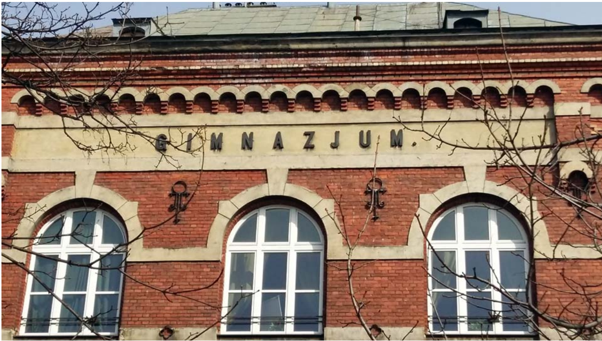
Ryc. 20. Widok na fragment elewacji frontowej budynku z napisem „Gimnazjum”. Fot. M. Krupa, 2016
