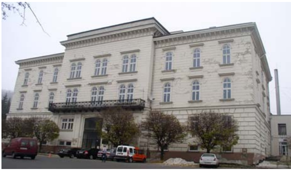
Fot. 6. Pałac Arcybiskupi we Lwowie – funkcję izolacji poziomej pełni system Mur-tronic, a od strony elewacji frontowej – również izolacji pionowej
