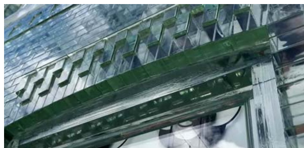
Ryc. 3. Zbliżenie na detal zwieńczenia okna – arch. własne Fig. 3. Close-up of architectural detail on window head – own archive
