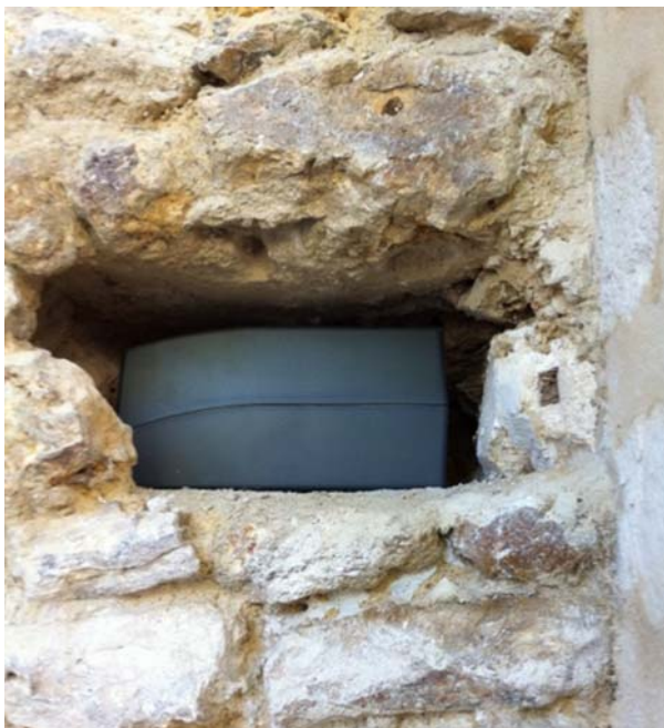
Fot. 3. Aparat Mur-tronic wprowadzony w głąb muru
