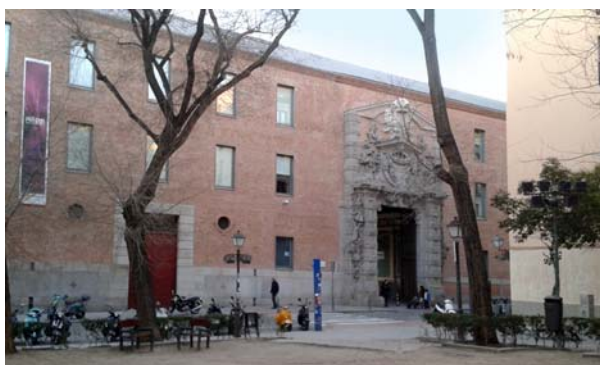
Ryc. 4. Conde Duque – widok fragmentu elewacji frontowej z portalem wejściowym – fot. autor (luty 2017)
