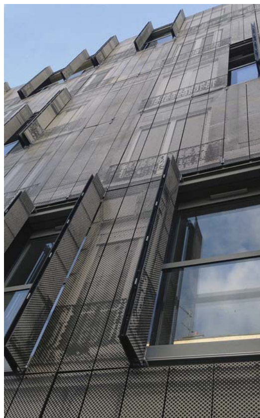
Ryc. 7. Zbliżenie na szczegół fasady – fot. Olga Wesołowska
