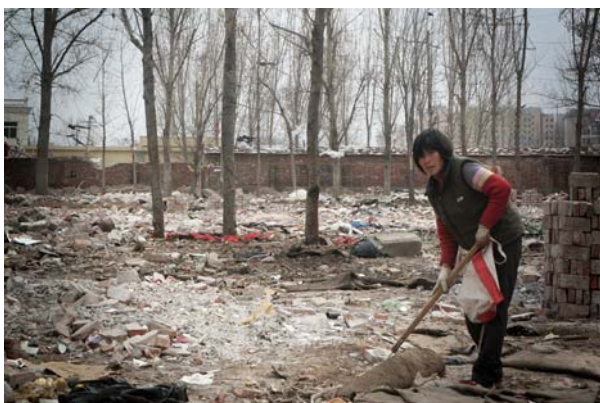
Ryc. 11. Rozebrane budynki dziedzińcowe w przygotowaniu do budowy bloków na obrzeżach Pekinu. Autor: Adam Chałupski, 2011
