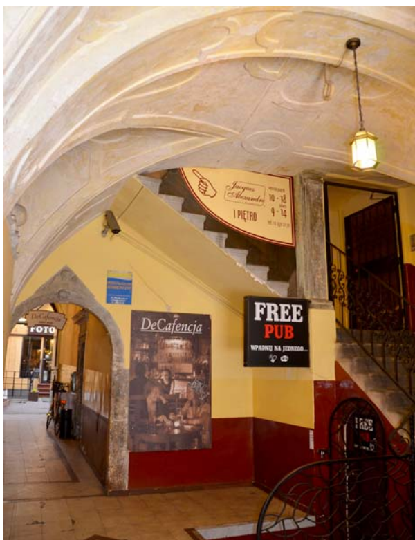
Ryc. 1. Kraków, sieni kamienicy, ul. Sławkowska 4 Fig. 1. Krakow, tenement entrance hall, 4 Sławkowska St.
