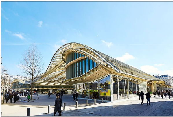
Ryc. 1. Paryż, obecna zabudowa na placu po wyburzeniu Hal Baltarda; http://berger-anziutti.com/ .
