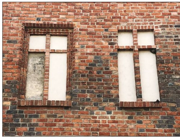
Ryc. 7b. Ratusz w Koźuchowie, elewacja północna, piętro, blenda, rok 2017; fot. A. Legendziewicz.
