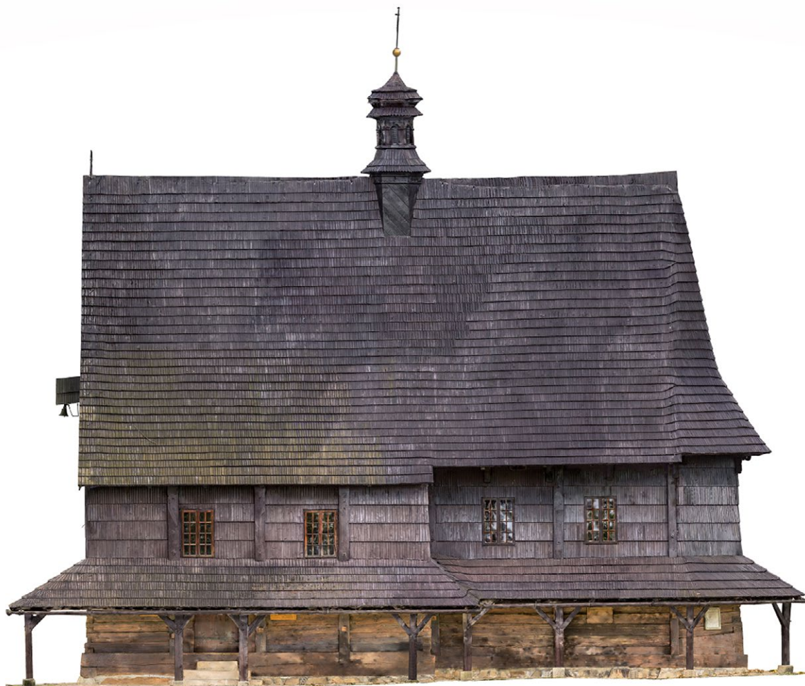
Ryc. 5. Elewacja kościoła, skan przestrzenny wykonany przez firmę 3delling, 2018. Fig. 5. Church facade, spatial scan performed by 3delling, 2018.
