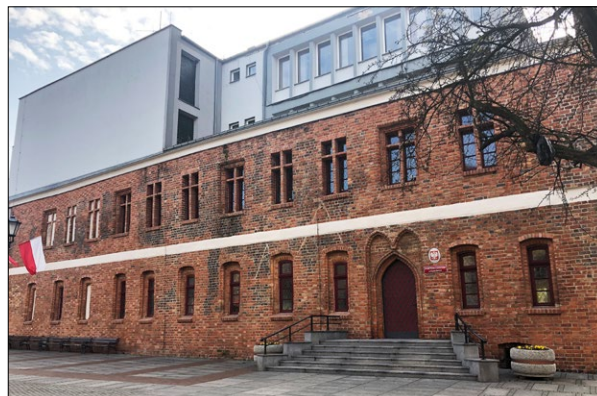
Ryc. 4b. Ratusz w Koźuchowie, elewacja północna, widok od północnego zachodu, rok 2017; fot. A. Legendziewicz.
