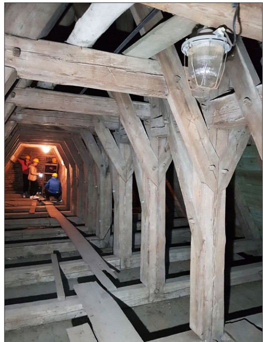
Ryc. 7. Wieżba storczykowa niezredukowana, po 1450 (d); oznaczenia: a – widok wężara od strony odwiązania, b – widok na ramę storczykową; fot. M. Prarat 2019.
