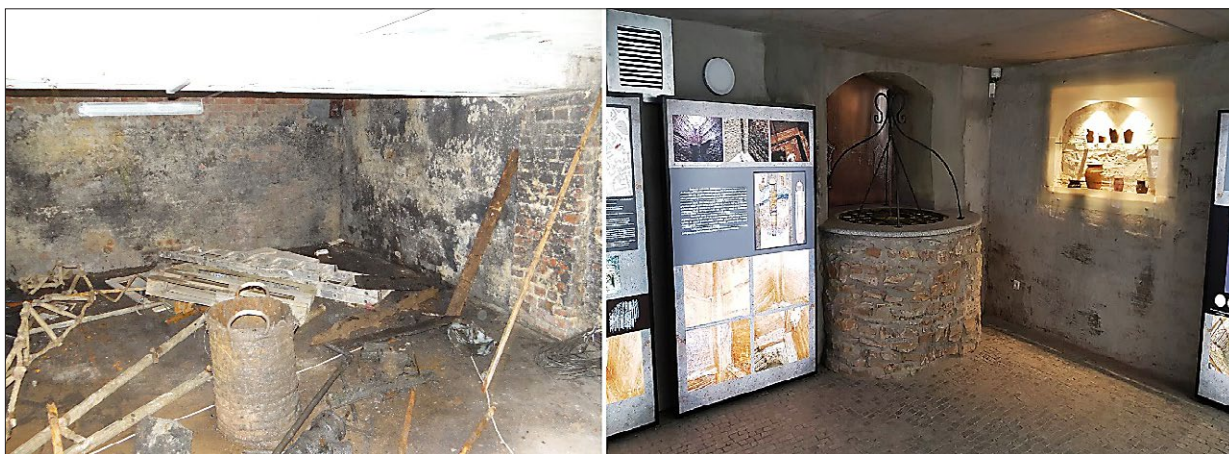
Ryc. 8. Wygląd piwnicy w roku 2012 i obecnie; oprac. D. Bajno, J. Ojdana.
