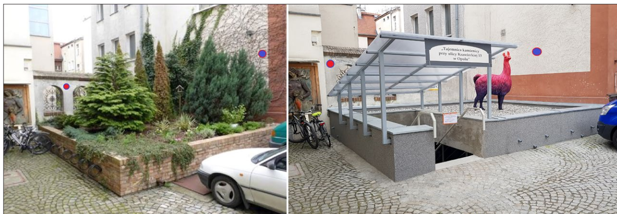
Ryc. 3. Widok piwnicy ze studnią: rok 2012 i stan aktualny; oprac. D. Bajno, J. Ojdana.
