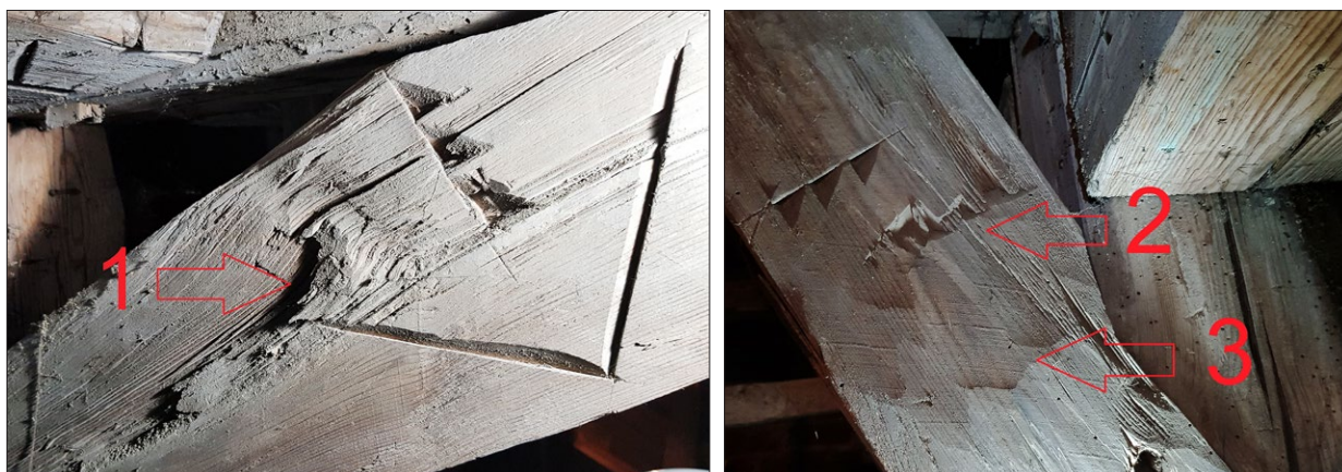
Ryc. 10. Fragment konstrukcji więźby dachowej: a) zastrzał ramy storczykowej, b) zastrzał wiązara; oznaczenia: 1 – ślad po rozłupaniu, 2 – ślad po uderzeniu siekierą, 3 – ślad po wyrównaniu budulca toporem; fot. M. Prarat 2019.
