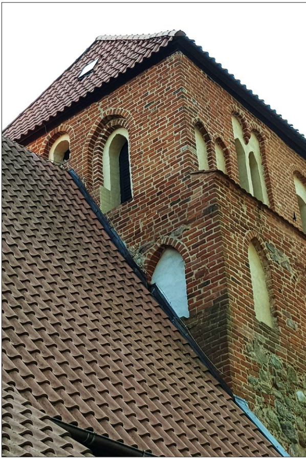
Ryc. 6. Widok na elewację wieży od strony południowej z okniem wyprowadzonym powyżej kalenicy; fot. M. Prarat 2019.
