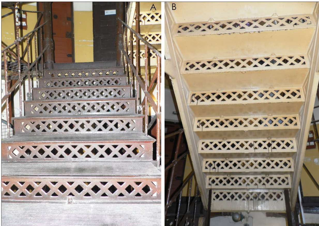
Ryc. 9. Bieg schodowy: A – widok od strony wchodzenia po schodach, ażurowa, geometryczna dekoracja podstopnic oraz prosta w wyrazie plastycznym balustrada; B – widok od strony podniebienia, konstrukcja montażu stopni; fot. Ł. Lewandowski 2015.
