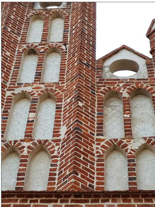
Ryc. 8. Szczyt wschodni z widocznym zrekonstruowanym rytym w blendach; fot. M. Prarat 2019.
