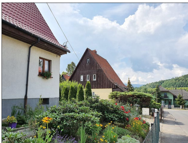
Fig. 4. Jelenia Góra, view of the gable wall of the house at 2 Skowronków Street, 2020; photo by M. Ostrowska-Bies. Ryc. 4. Widok ściany szczytowej budynku przy ul. Skowronków 2 w Jeleniej Górze, 2020; fot. M. Ostrowska-Bies.
