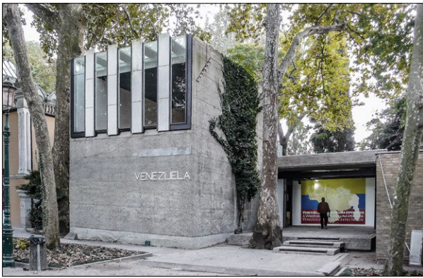
Fig. 4. Detail of the concrete facade of the Venezuelan pavilion for the Venice Biennale, 2008; photo by M. Twardowski. Ryc. 4. Detal betonowej elewacji pawilonu wenezuelskiego na Biennale w Wenecji, 2008; fot. M. Twardowski.
