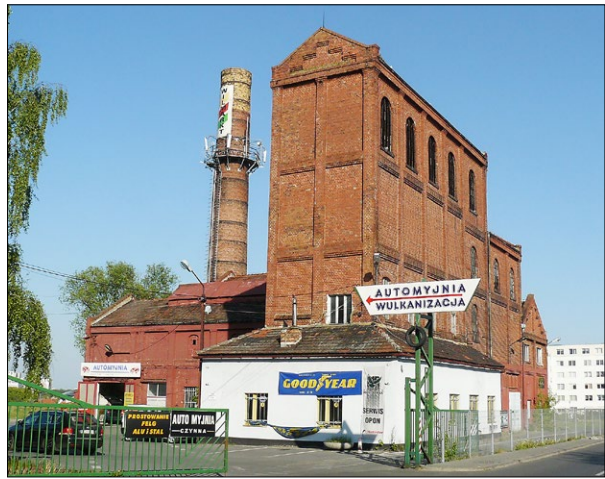
Fig. 4. Incineration Plant, image from 2007 showing the missing smokestack top and the additions on the ground level; photo courtesy of Litoborski+Marciniak. Ryc. 4. Spalarnia, zdjęcie z roku 2007 ukazujące brakujący wierzchołek komina oraz dobudówki na poziomie parteru; fotografia dzięki uprzejmości Litoborski+Marciniak.
