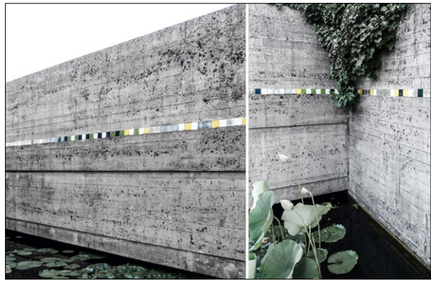
Fig. 5. Details of the south wall of the Brion funerary complex, 2015; photos by A. Ros Campos. Ryc. 5. Detale ściany południowej kompleksu cmentarnego Brion, 2015; fot. A. Ros Campos.
