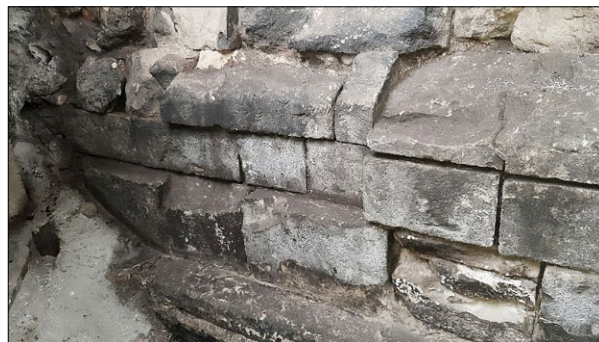
Ryc. 6. Zachowany fragment frontowej elewacji z ciosów kamiennych II romańskiej bazyliki pw. Trójcy Świętej i Marii Panny, wykop archeologiczny przy zachodniej elewacji kolegiaty w Wiślicy, 2020; fot. autorzy
