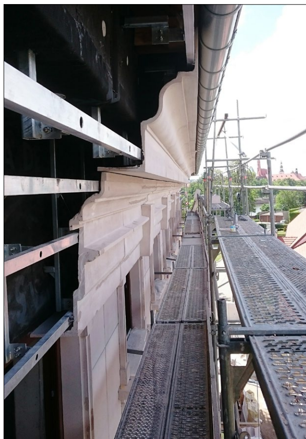
Ryc. 8. Technologia wykonania elewacji z betonowych płyt GRC na podkonstrukcji aluminiowej, 2016; fot. J. Gomółka
