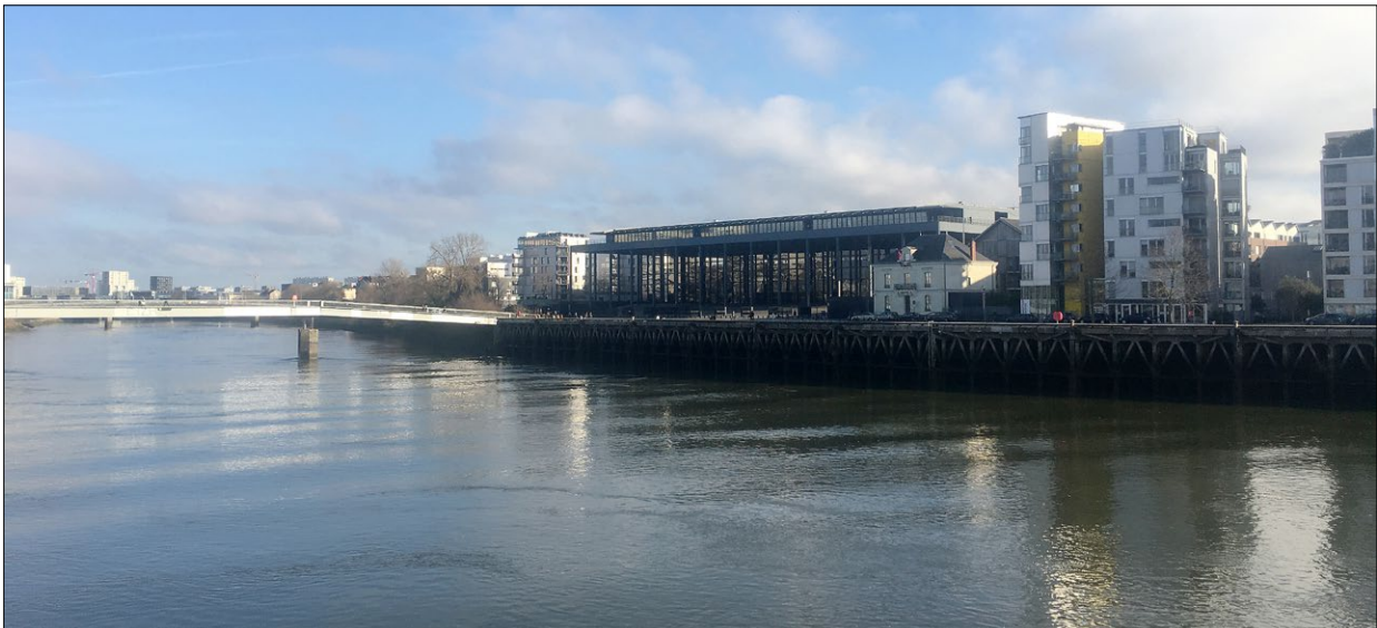
Ryc. 3. Panorama Île de Nantes od strony centrum miasta, w środku widoczny gmach sądu oraz prowadząca do niego kładka; fot. autorka Fig. 3. A panoramic view of Île de Nantes from the city center, the courthouse and the footbridge leading to it are visible in the middle; photo by the author
