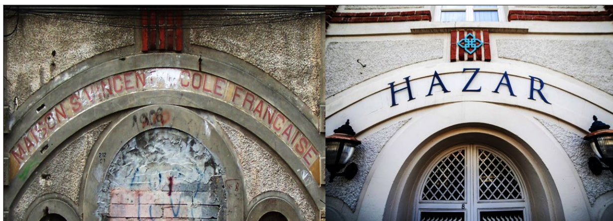
Fig. 10. The sign on top of the entrance – before and after the restoration; photo by H.A. Doğan Ryc. 10. Znak nad wejściem – przed i po rewaloryzacji; fot. H.A. Doğan
